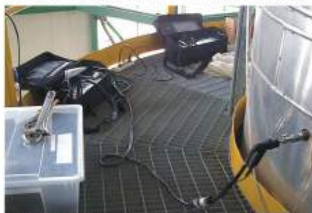
Analizzatori portatili di gas esausti in uso sul camino di un termoutilizzatore
