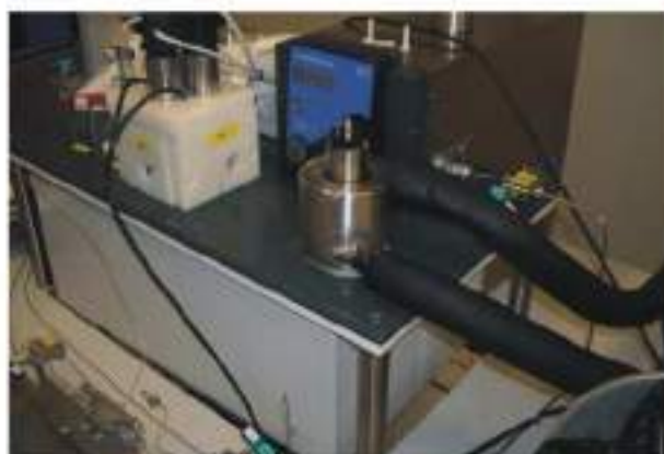
Bagno termostatico principale del banco per miscele monofase
