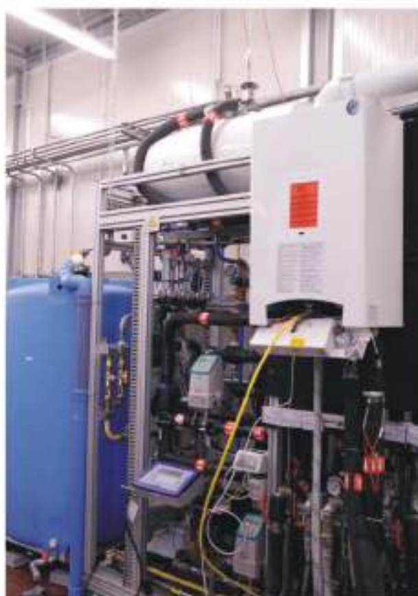
Caldaia murale a gas in prova nel laboratorio heat_box
